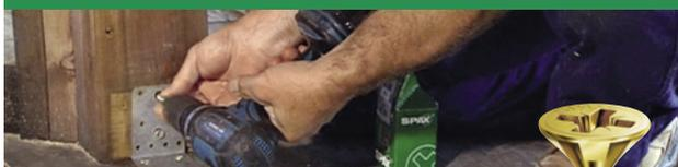
Verschraubung von Beschlägen mit Durchgangsloch, z. B. an Holzbalken.
